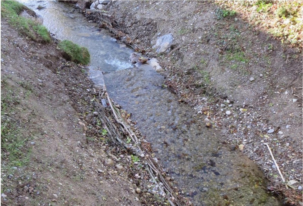
(neue seitliche Bachböschung mit Faschinen und Schwelle)
