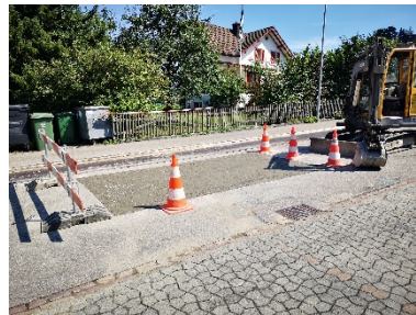
provisorischer Belageeinbau mit Betonkies
